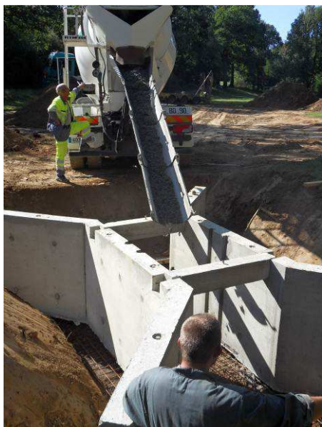
Ouvrage en construction
