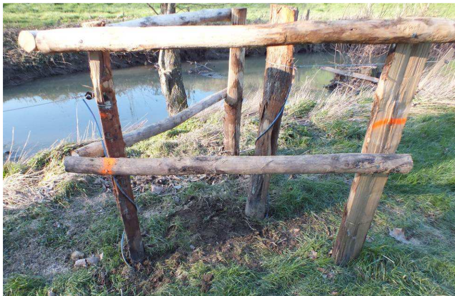
Exemple de chicane sur le bassin de l'Evre
