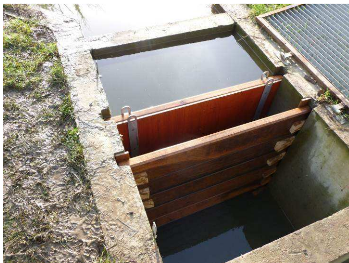
Ouvrage de régulation avec madriers et caillebotis
